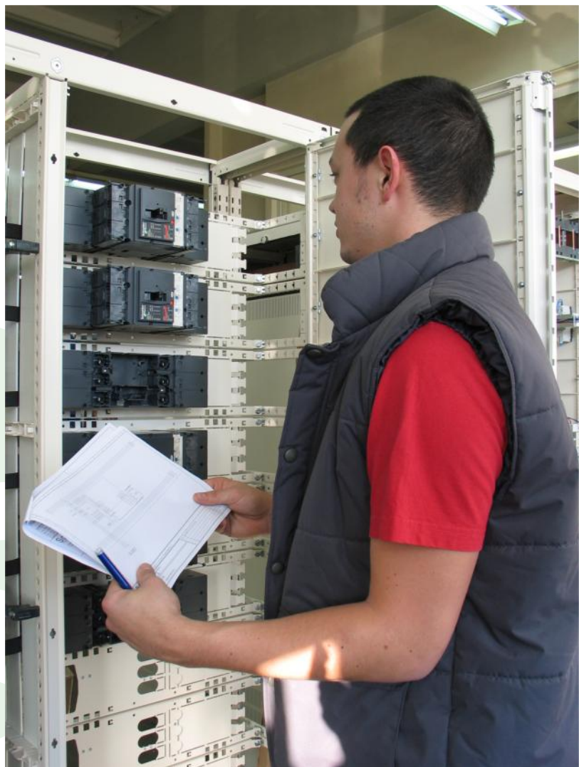
Contrôle visuel périodique réalisé par un technicien spécialisé
