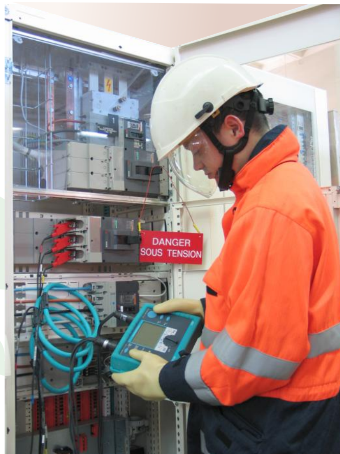
Un technicien, protégé par son équipement, en train d'effectuer des mesures. Le travail est effectué sous tension.
